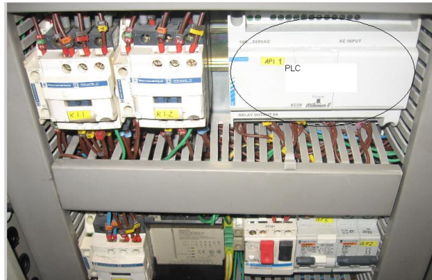
Resim 2.28: Yürüyen merdiven sisteminde kullanılan bir PLC
