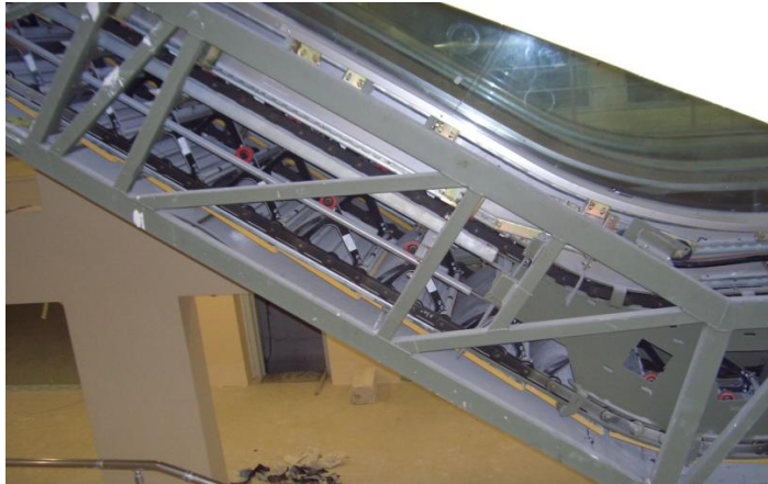
Resim 1.9: Yürüyen merdiven iskeleti detay
