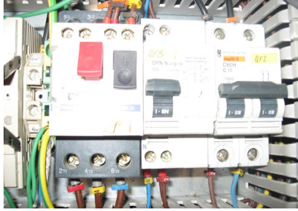
Resim 2.18: Koruma röleleri ve otomatik sigorta
