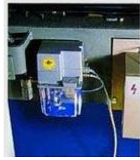
Resim 3.26: Yürüyen merdiven/yol sistemi otomatik yağlama motoru ve yağ deposu
