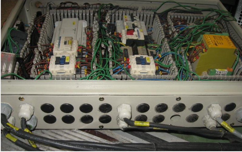
Resim 2.6: Ana panoya gelen ve giden bağlantılar
