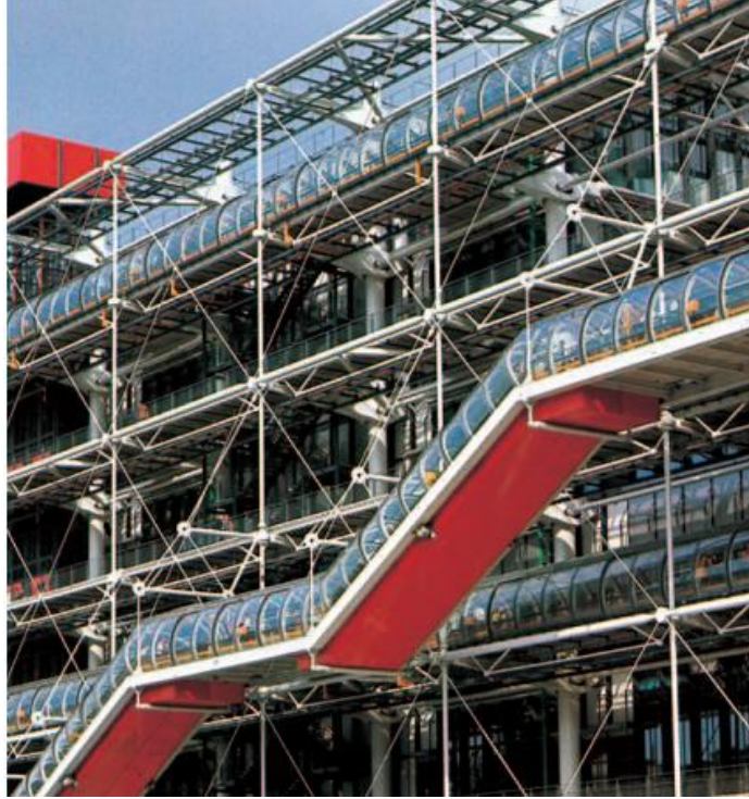
Resim 1.6: Yürüyen merdiven ve yol sisteminin birlikte kullanılması
