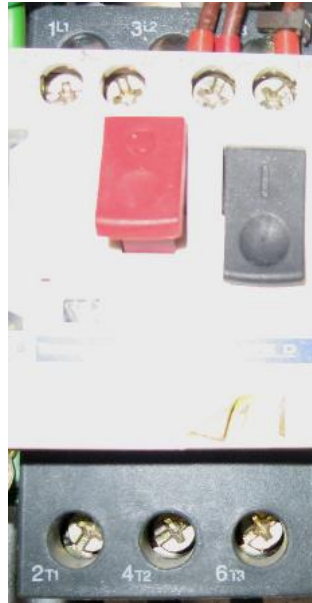
Resim 2.20: Yürüyen merdiven panosunda kullanılan motor koruma rölesi
