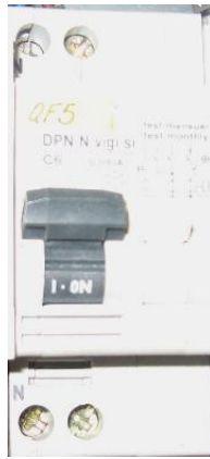
Resim 2.19: Yürüyen merdiven panosunda kullanılan kaçak akım rölesi
