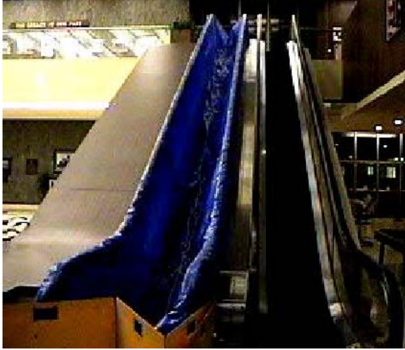
Resim 1.12: Tek parçalı yürüyen merdiven
