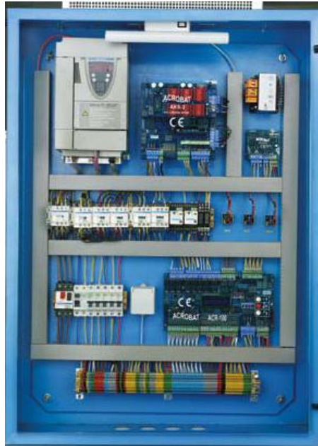
Resim 3.18: Pano ve VVVF hız kontrol cihazının montajı
